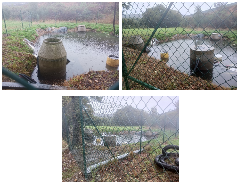
Imaxe 15: EDAR O Empalme
